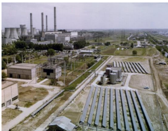
Centrala solaro-electrică cu captatoare plane și turbină cu fluide organice [8]
