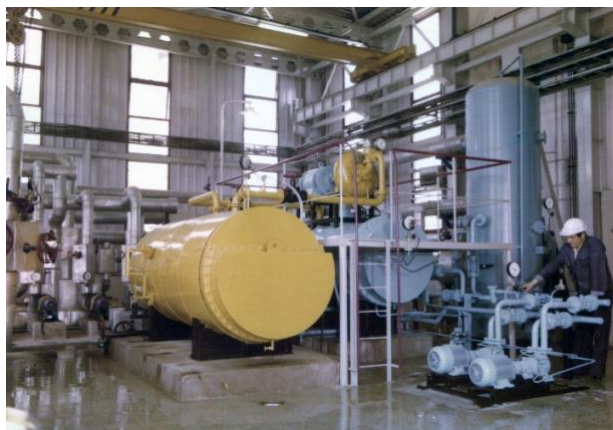
Centrala solaro-electrică cu captatoare plane și turbină cu fluide organice [8]
